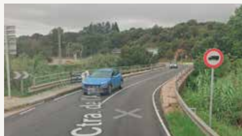
Pont ctra. de l'Ametlla
